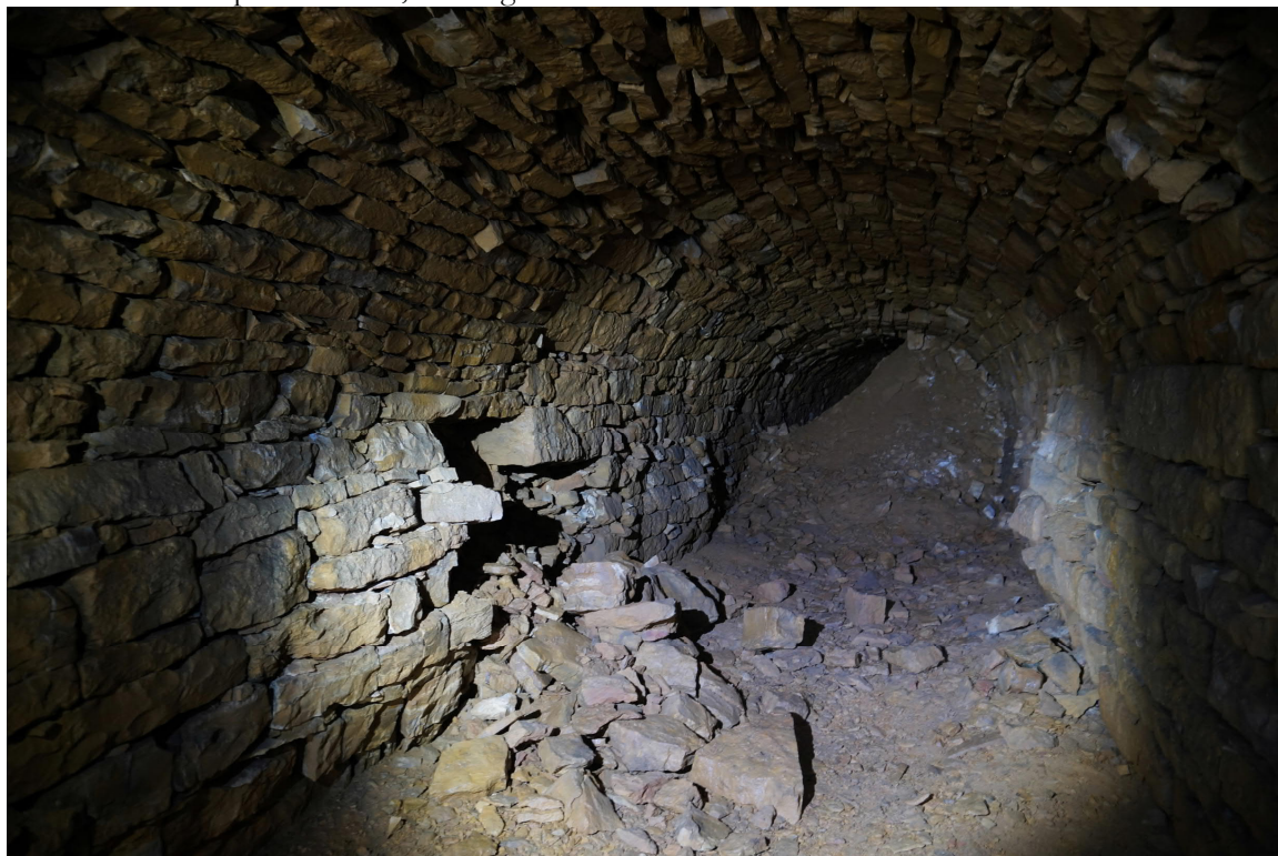
Fig. 34 : Couzon-au-Mont-d'Or, Moletant : déchaussement des murs et voûte affaissée.
