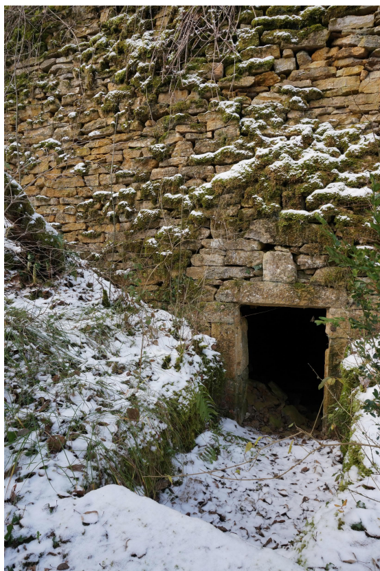
Fig. 26 : Les Grandes Torelles : Terrasse en pierre sèche (hauteur : 10 mètres environ).
